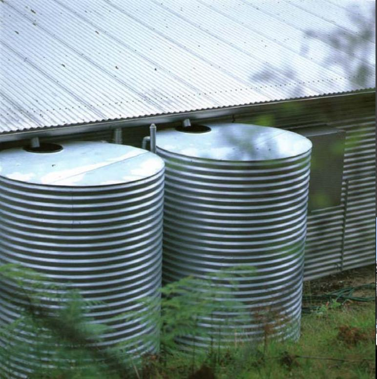
主屋與車庫間有一人工水池，配合屋後雨水收集桶，可提供夏日每天五、六小時建物噴水冷卻所需
