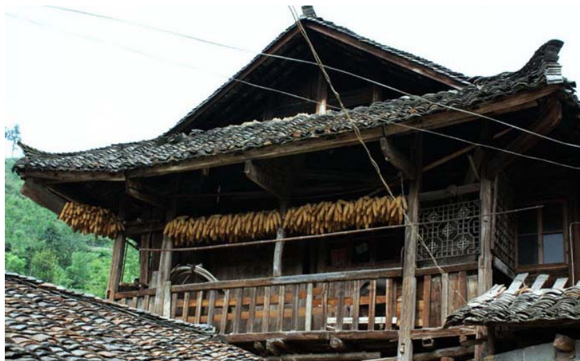
吊脚楼的屋顶形式
