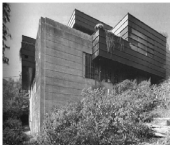
圖 9/10.RC、開口與木構架的模矩化整合
