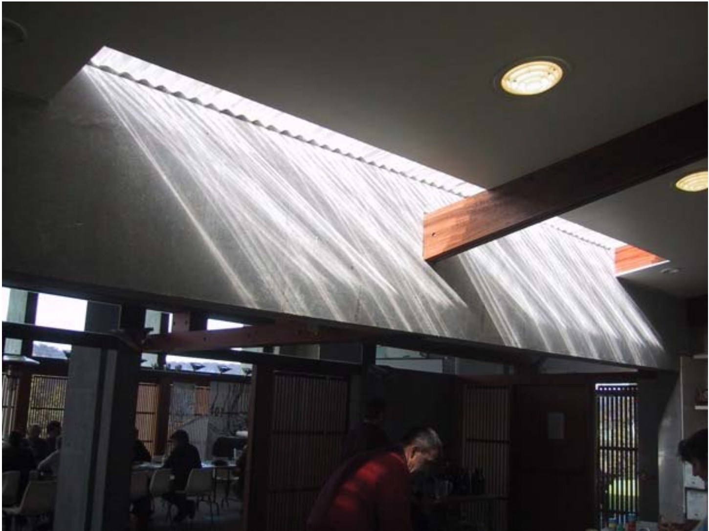
連接大廳與服務空間的中廊，以線型的天窗拉高了空間的尺度，半透明的塑膠浪板材料變成光影的繪畫
