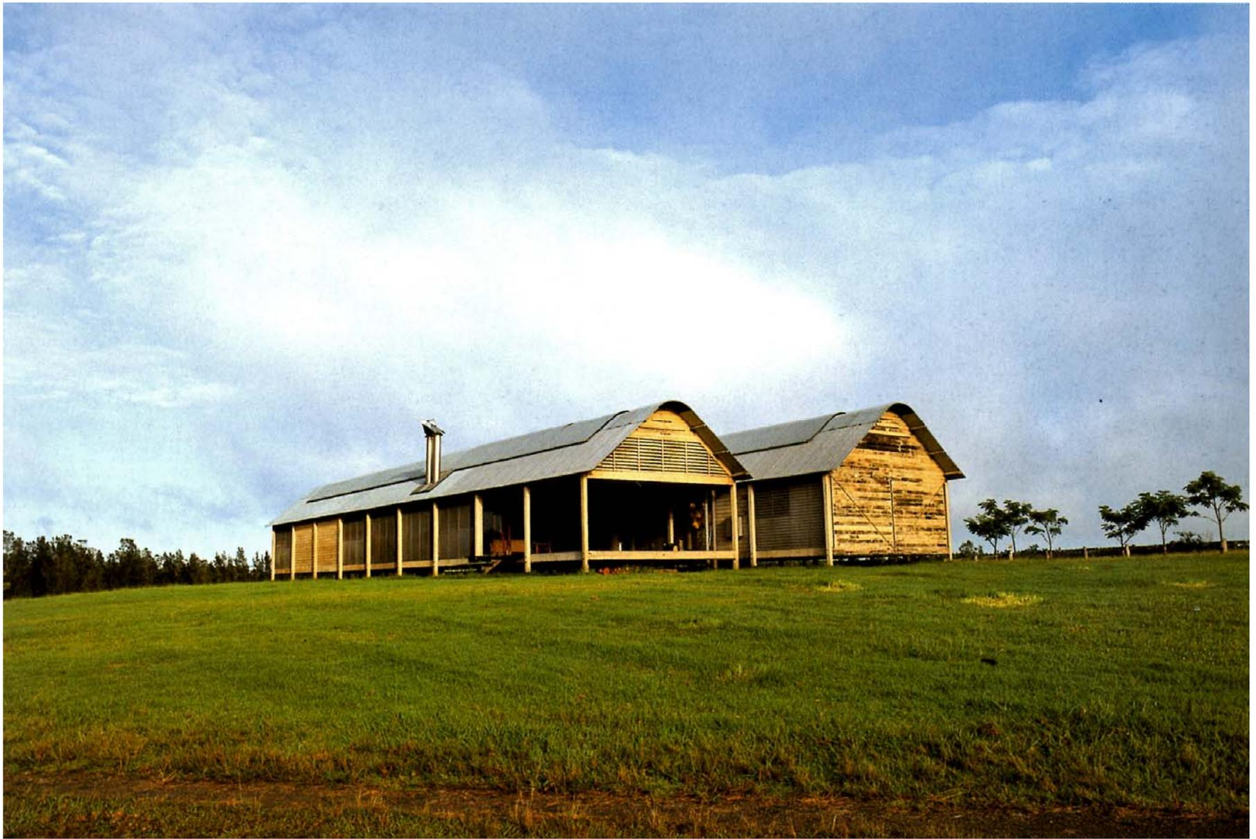
採用簡單的構築方式，以當地的技術、當地建造農家小屋的工法、當地的材料建造：
